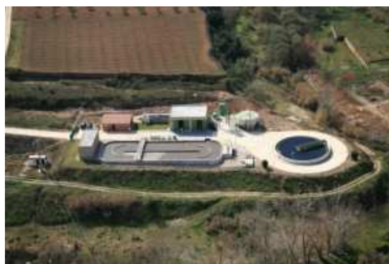
EDAR de l'Espluga de Francolí
