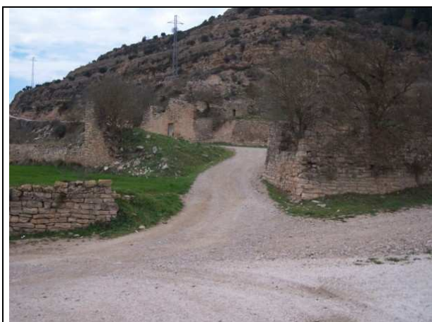
Estat inicial: Camí dels Penjats Vallfogona
