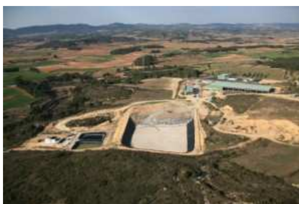
Centre Comarcal de Tractament de Residus
