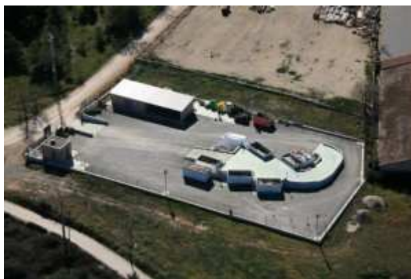
Deixalleria comarcal de l'Espluga de Francolí
