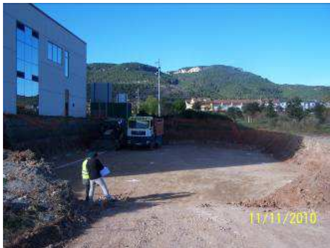
Imatge de la construcció del nou edifici
