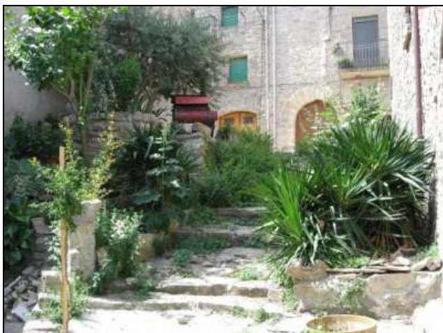
Inici de la rehabilitació
