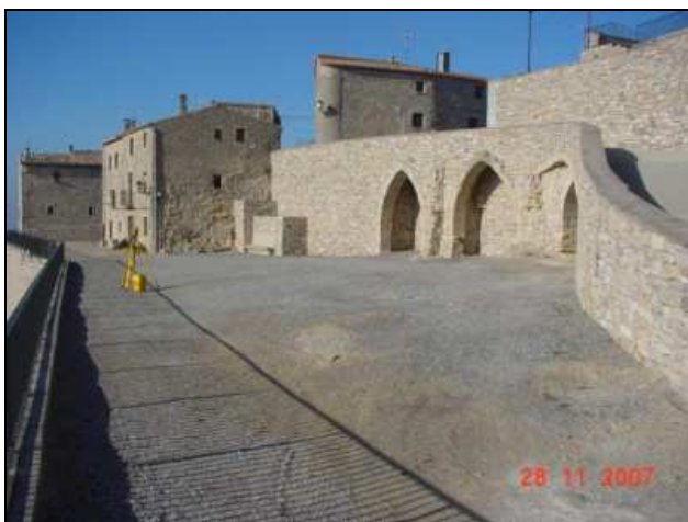
Inici de la rehabilitació
