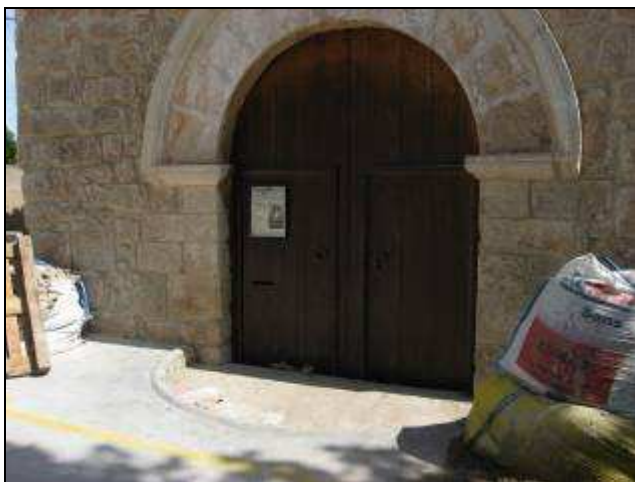
Inici de la rehabilitació
