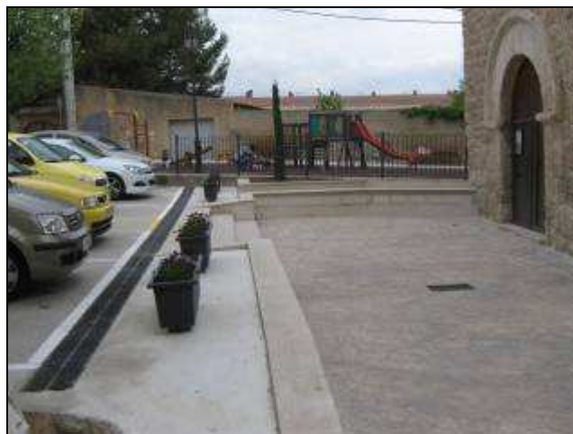
Estat final de la rehabilitació
