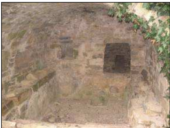
Inici de la rehabilitació
