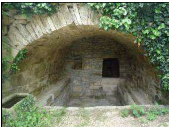
Estat final de la rehabilitació
