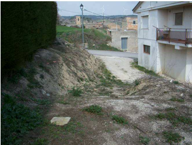
Accessibilitat al consultori mèdic Conesa Inici rehabilitació
