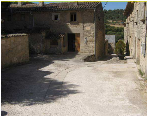
Arranjament carrer Raval de la Creu Senan Inici arranjament
