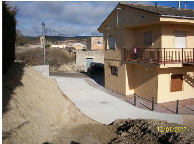
Estat final de la rehabilitació
