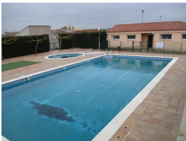
Adequació piscina municipal Conesa Inici obres
