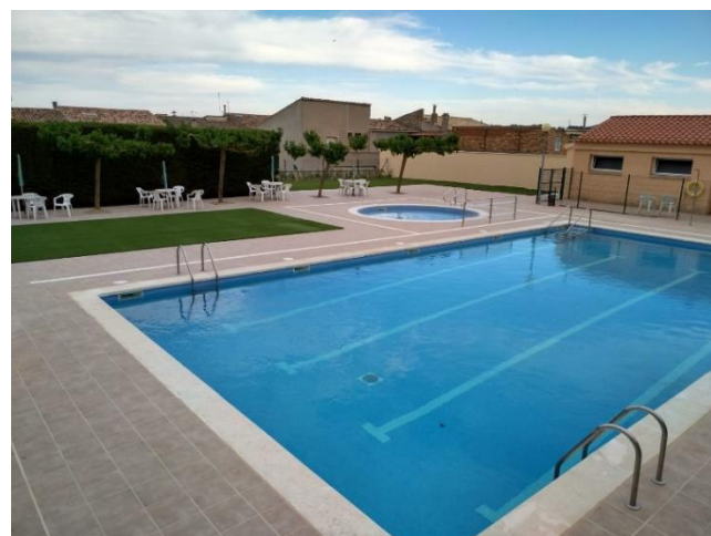
Estat final de l'actuació
