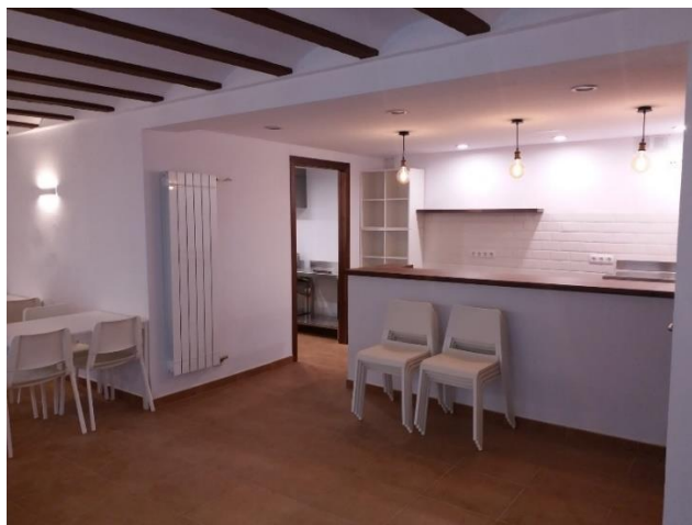
Estat final de l'actuació
