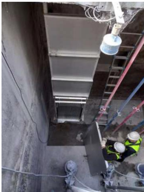
Col·locació i posada en marxa de la reixa automàtica – EDAR Montblanc
