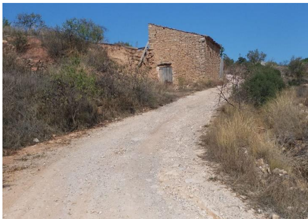
Arranjament camí Pedreres Solivella Inici obres
