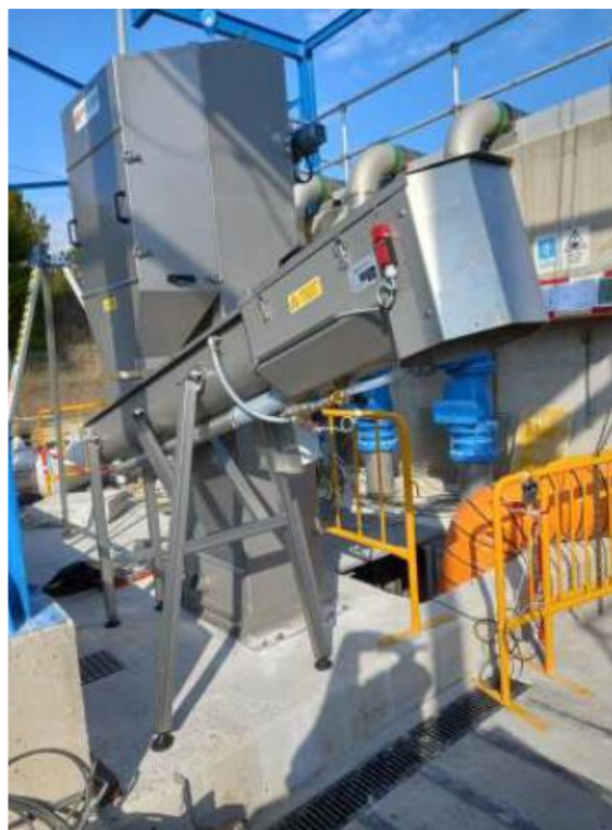
Col·locació i posada en marxa de la reixa automàtica – EDAR Montblanc
