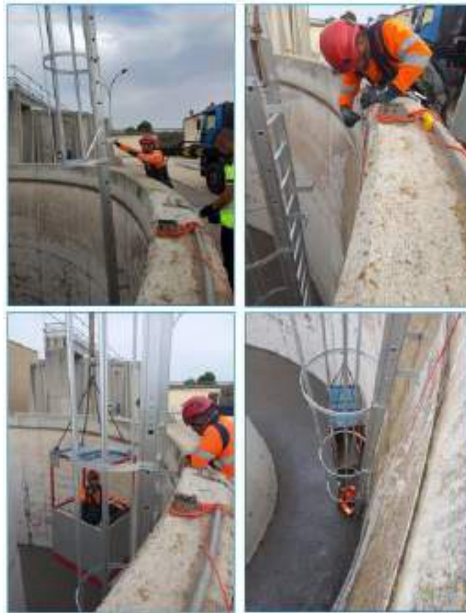
Muntatge escales de gat i embarcament del reactor biològic núm. 1 de l'EDAR de Montblanc
