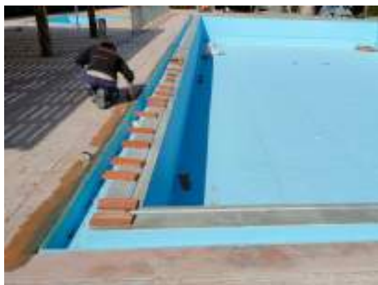
Treballs de millora de la piscina
