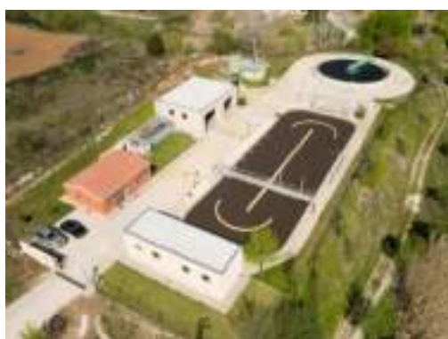
EDAR Espluga de Francolí
