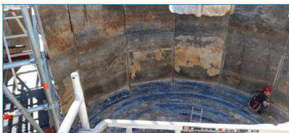
Reparació de l'espessidor EDAR Montblanc
