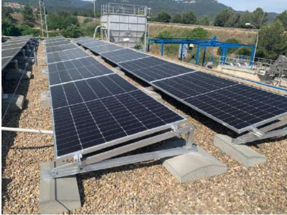
Instal·lació plaques fotovoltaïques EDAR Montblanc
