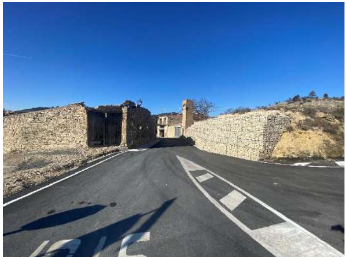
Estat final carrer Muntanya
